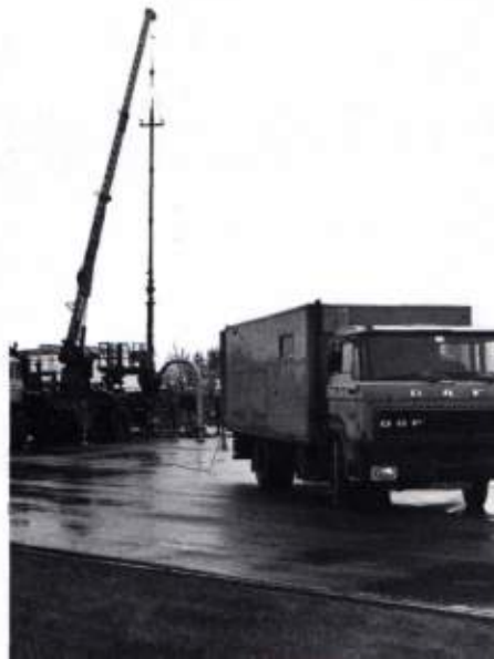
Wireline-werkzaamheden op locatie.
