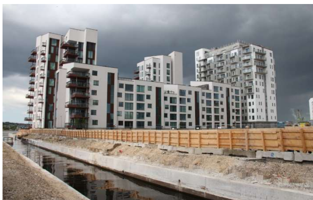
Byggeri på Aalborg Havnefront
