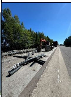
Förläggning av media på GC-väg
