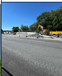
Mark- & kanalisationsarbeten för MT04
