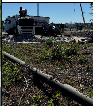
Styrd borrhning under väg från logistikhubb till GC-väg 20kv
