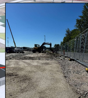
Gjutning av fundament för nya skalskyddet
