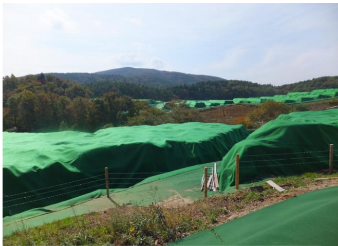
Mellanlager för sanerad jord och växtmaterial
