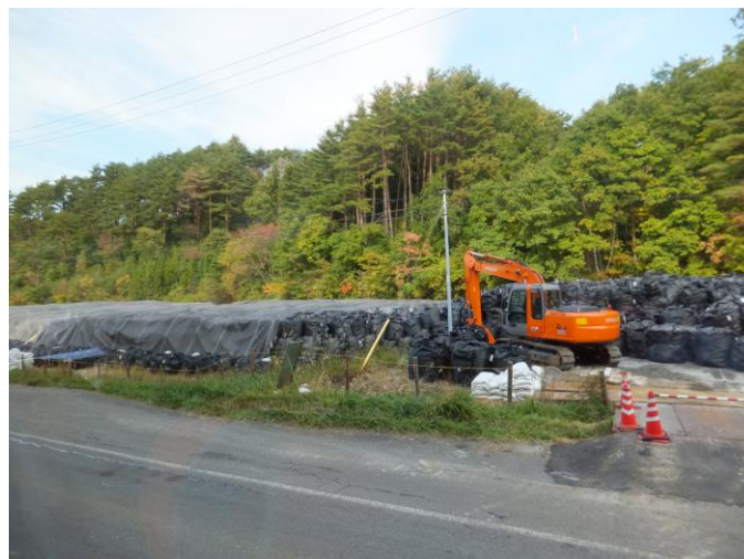
Plastsäckar för sanerad jord och växtmaterial
