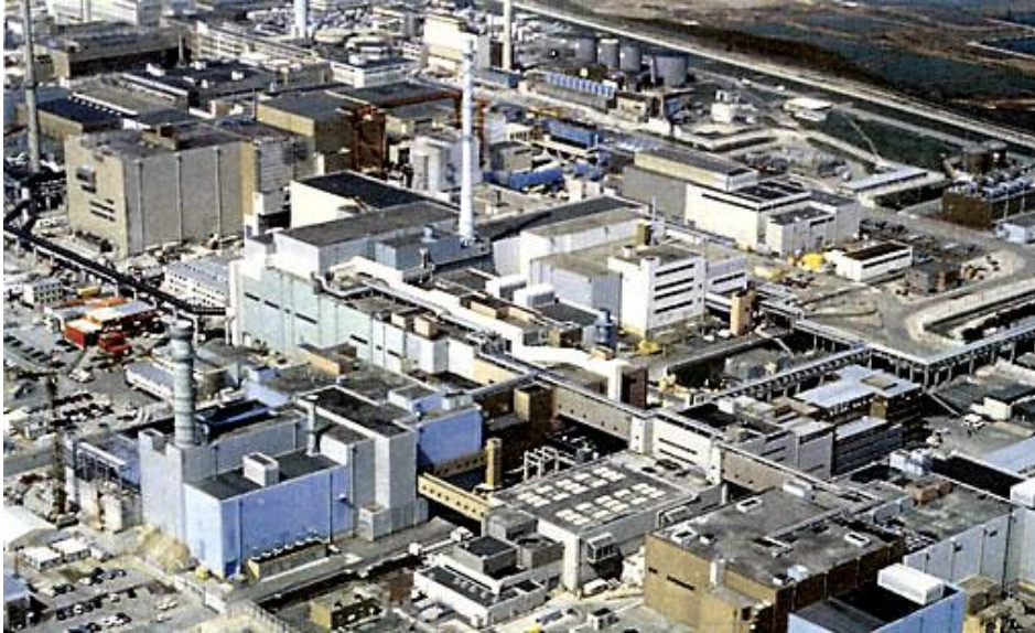
Figur 6 Flygbild över upparbetningsanläggningarna vid la Hague
