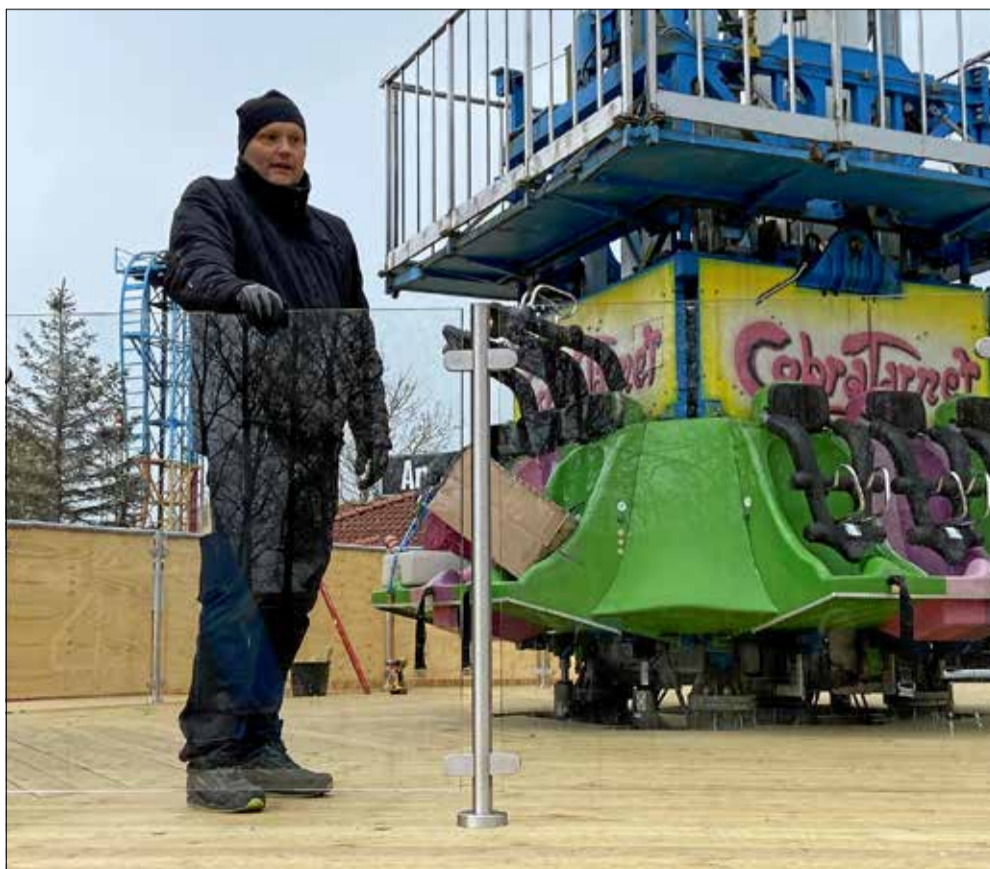
Glamster Kenneth Sørensen er godt i gang med at sætte glasværn op rundt om Cobratårnets nye platform.
