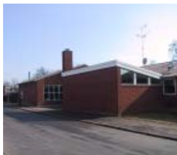
Institutionen ved Kærskiftevej med nyere tilbygning.
