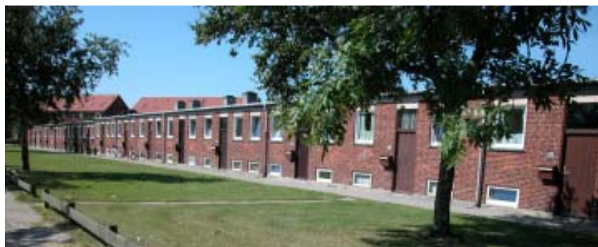
Rækkehusenes takfaste facade set fra Vigerslev Allé. Flere af de oprindelige skorstene er fjernet.
