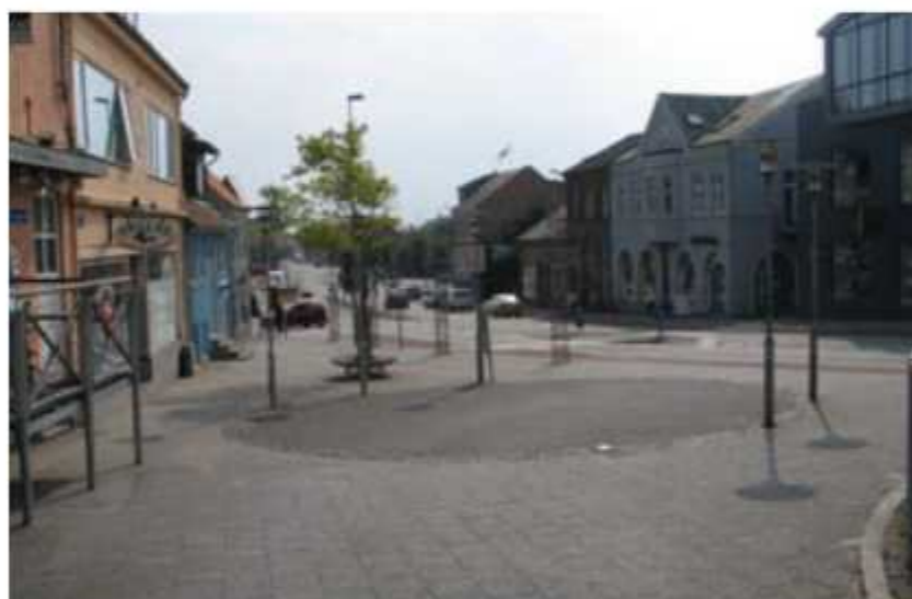
Udifferentieret, utilpasset belægning, Thinggade/ Øster Torv
