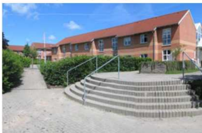
Udifferentieret, karakteristisk belægning, Thorupsgade
