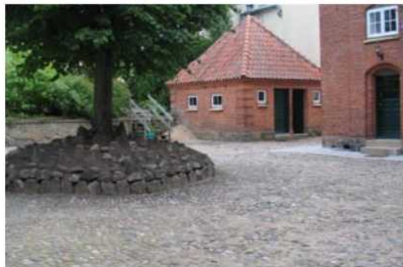
Karakteristisk, enkel belægning, Adelgade 16
