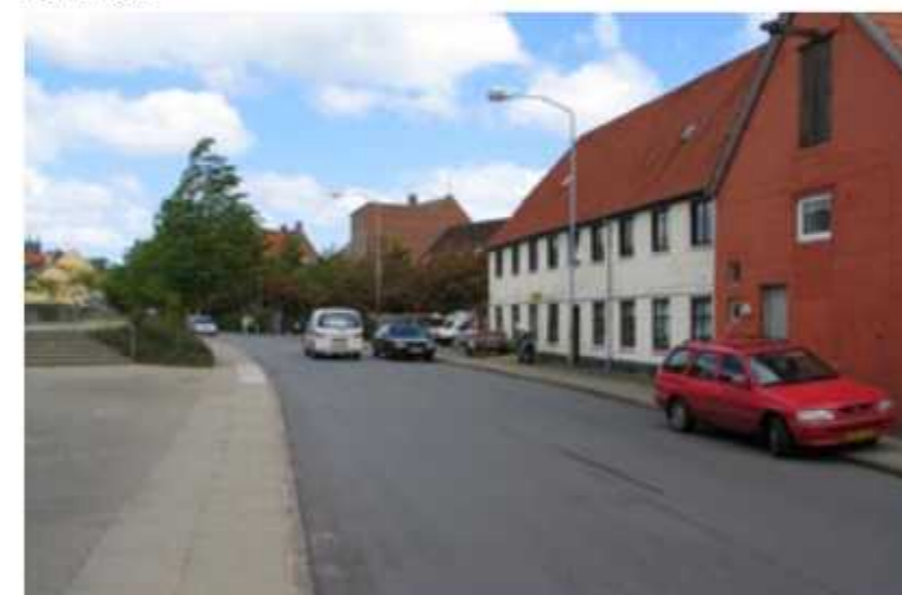
Utilpasset belysning/ armatur (orienteringsbelysning), Thorupsgade
