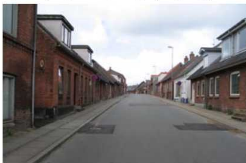
Utilpasset belysning/ armatur (orienteringsbelysning), Thomsensgade
