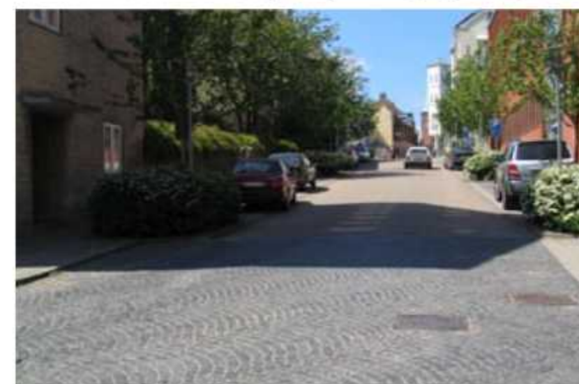
Karakteristisk, differentieret, tilpasset gadebelægning, Slotsgade
