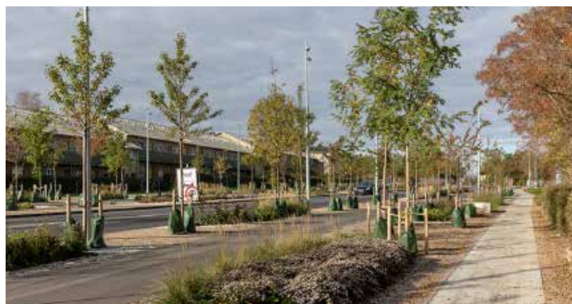
Ballerup Boulevard - Omlægning fra 4 til 2 spor, trafikdæmning med planter og træer
