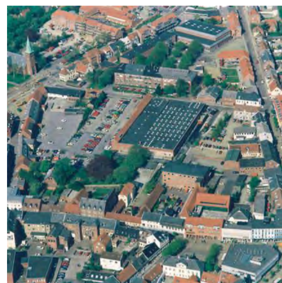
LUFTFOTO, ASYLGADE KARRÉEN
