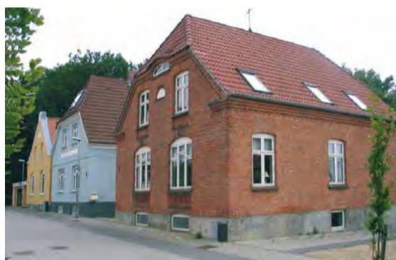
BEDRE BYGGESKIK, ANLÆGSGADE 4
