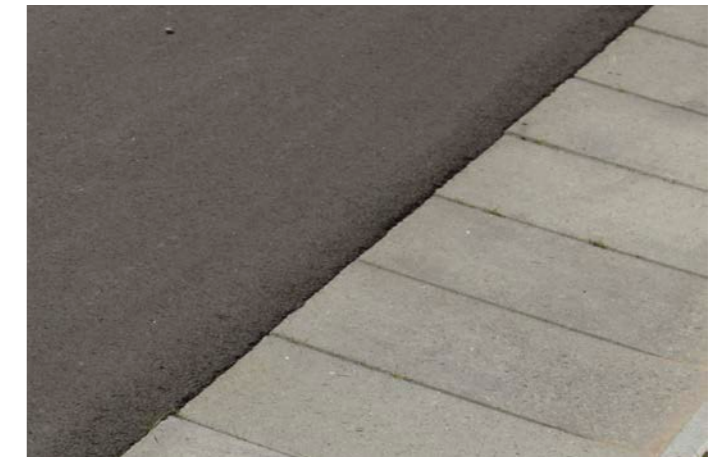
Kanter til den asfalterede vej dannes af fliser, som ligger i niveau med vejen.
