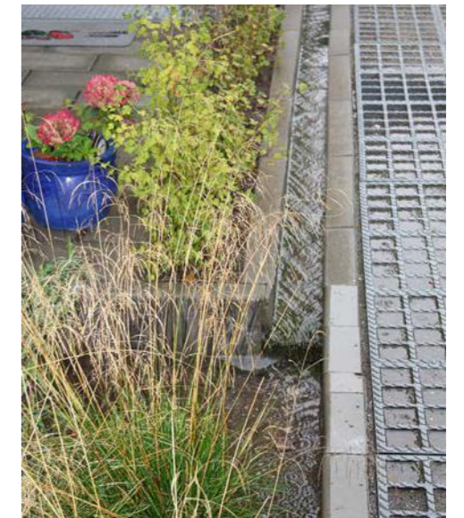
Render leder regnvand mod grøfter
