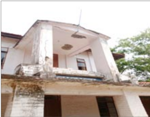
Husfasaden före renoveringen
