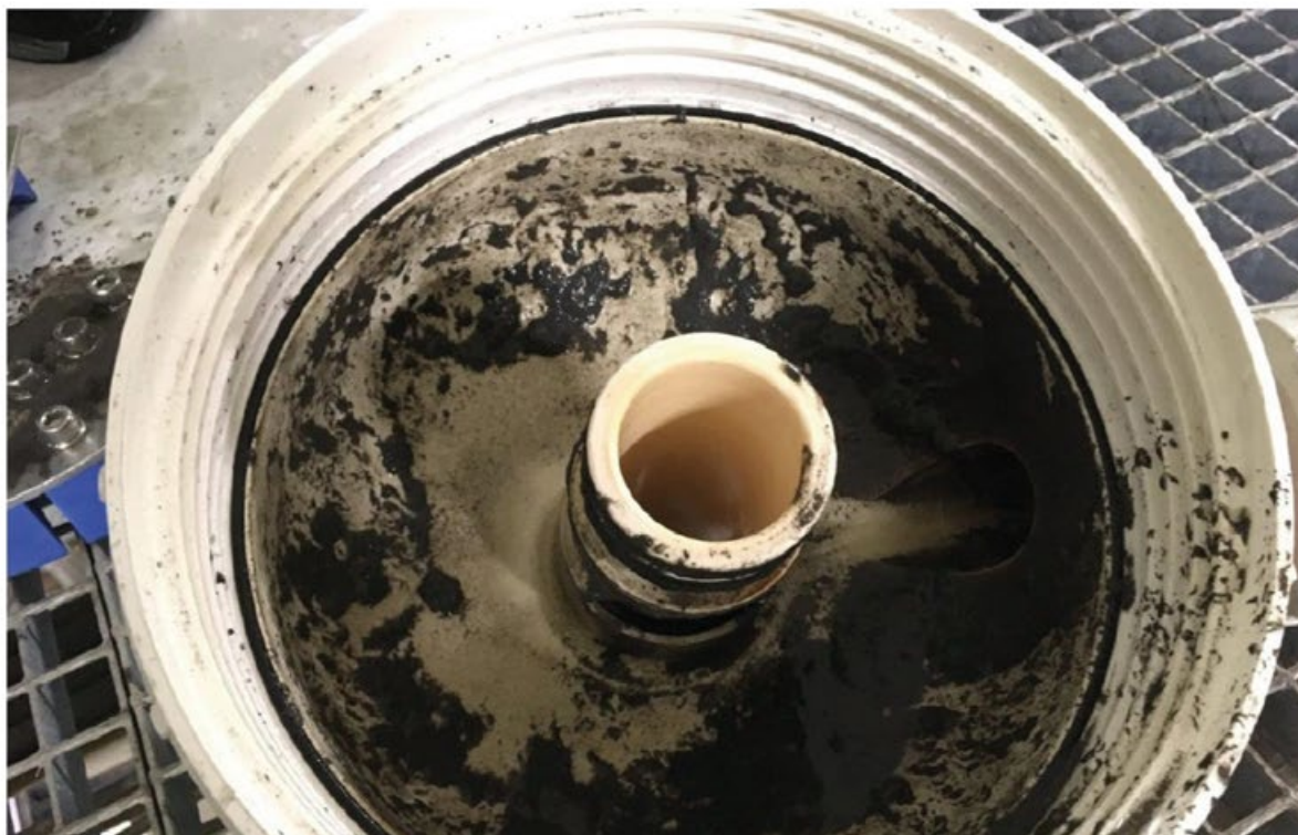
En av de största utmaningarna för anläggningar som renar rökgaskondensat är att filtren förorenas av mikroorganismer. FOTO: JAN LUNDGREN
