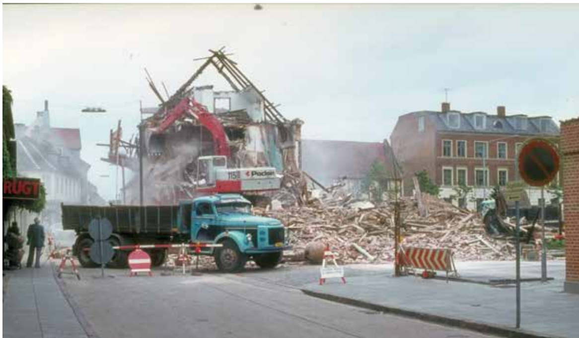
Nedrivning i forbindelse med gadegennembruddet ved Lundegade og Kongensgade, 1975. Foto: Per Godtfredsen.
