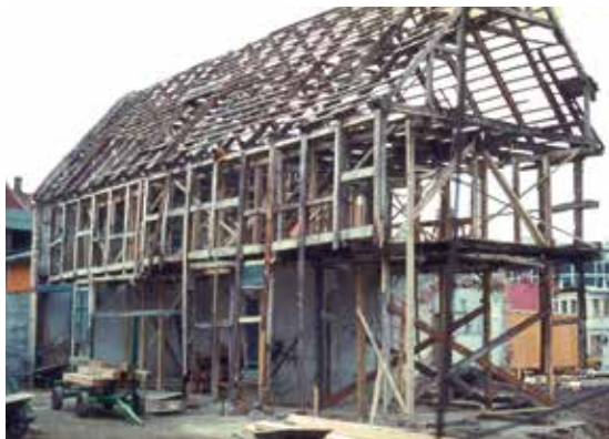
Kongensgade 2E under renovering, 1970'erne. Foto: Per Godtfredsen.
