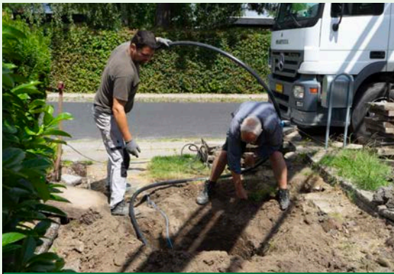
Jordvarmespiralen er monteret perfekt i hullet.
