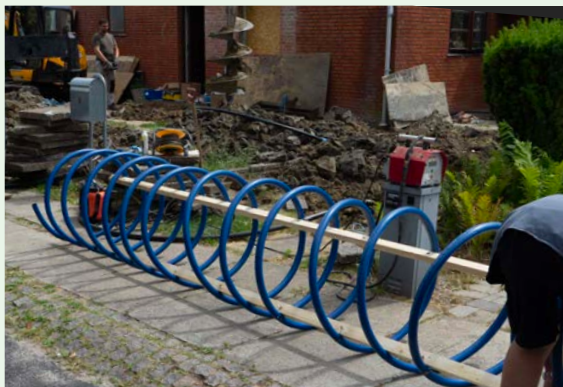
5 meter spiral klar til montage.
