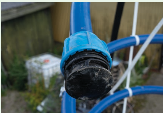
Spiralen monteres til jordvarme-anlægget.
