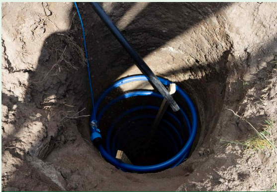
Spiralen klar til at tilslutte.
