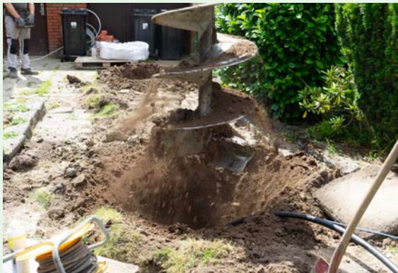
Boring af det første hul i op til 5 meters dybde.
