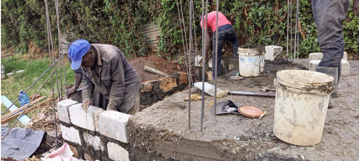
Fler toaletter byggs vid Redhill Baraka School.
