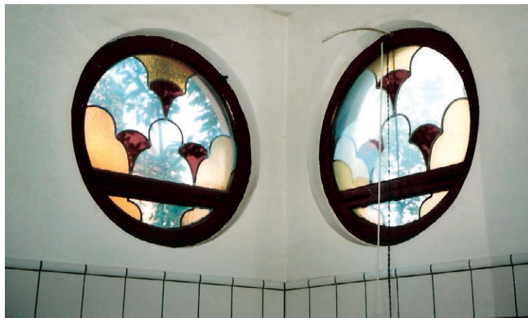
De to toiletvinduer på 1. sal
