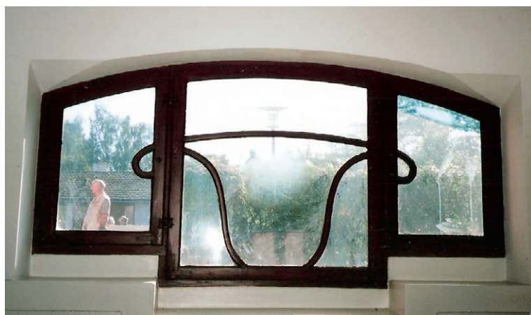
Køkkenvinduet ud mod Strandagervej
