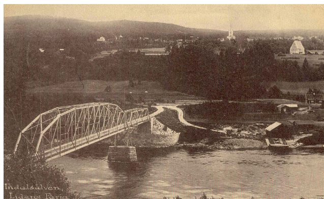
Första bron (1914) över Indalsälven vid Liden var en järnkonstruktion. Bron blev ungefär 40 år gammal när den ersattes av den nuvarande betongbron i mitten av 1950-talet pga. tillkomsten av Bergforsens kraftverk. Lidens båda kyrkor syns i bakgrunden. Fotot är brunaktigt s.k. sepiafärgat. Foto ur Bengt Hammarbergs vykortssamling.
