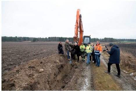
Fibergrävning utförs i möjligaste mån längs åkerkanter.
