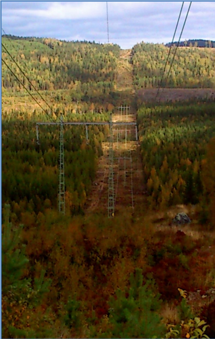
Bild 9. Befintlig 220 kV ledning KL1. Ledningsalternativ 1 och 3 innebär en breddning av västra kanten av ledningen
