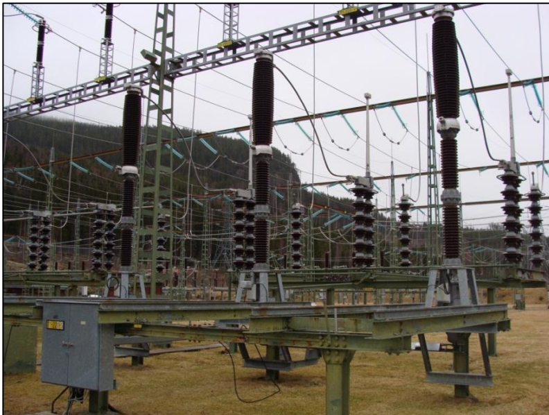
Bild 5. Ledigt fack för utmatning till stamnätet
