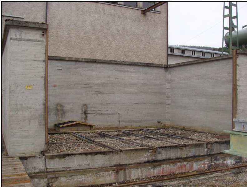
Bild 6: Ledigt transformatorbås i Krångede
