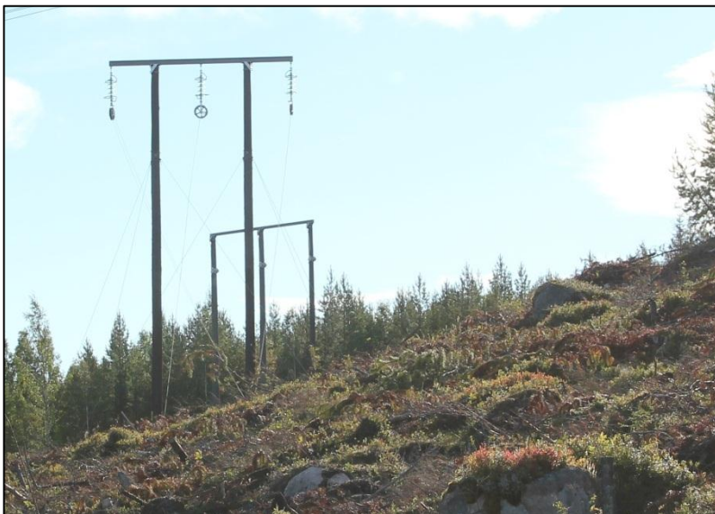
Bild 7: Byggnation av liknande ledning
