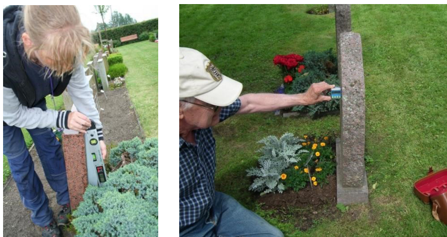
Figur 14. Kontroll av lutning med vinkelindikatorer.
