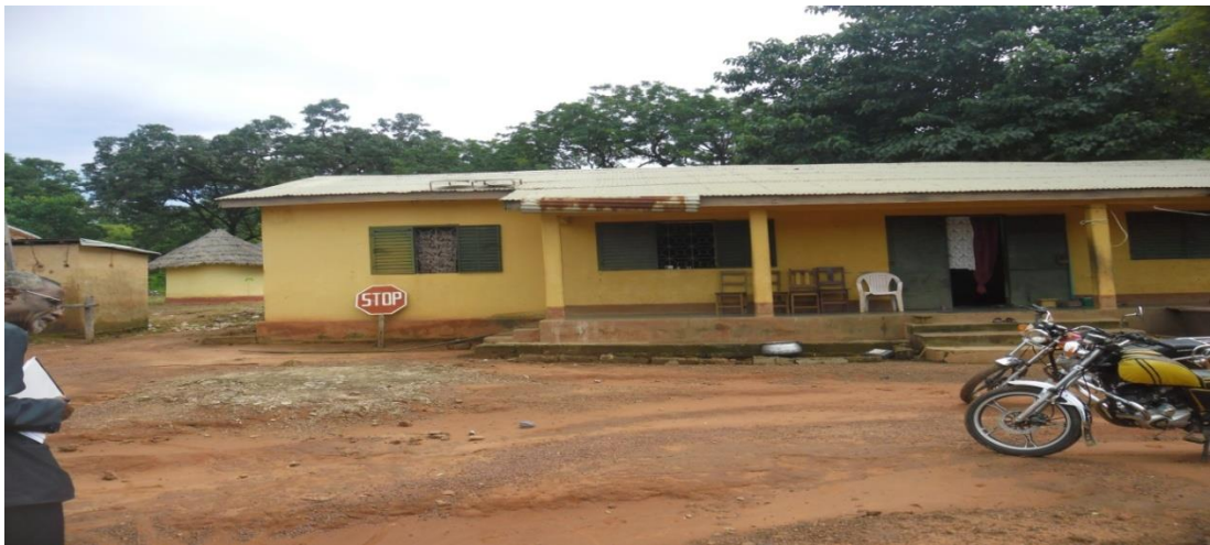
Bâtiment administratif à Siguirini (Financement CDL SMD)
