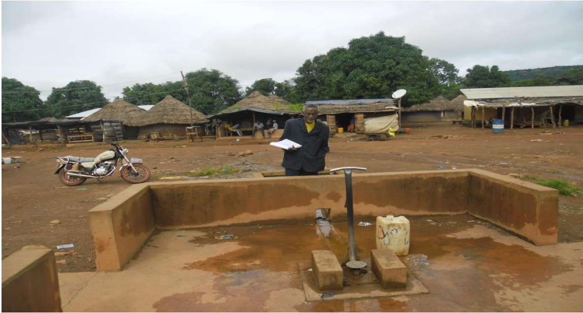
Forage d'eau avec pompe vergnet au village de Fayala, sur financement SMD
