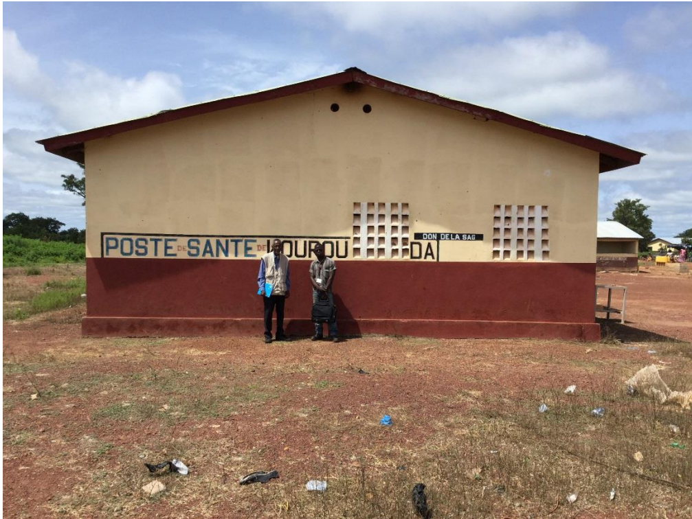
Poste construit sur financement SAG
