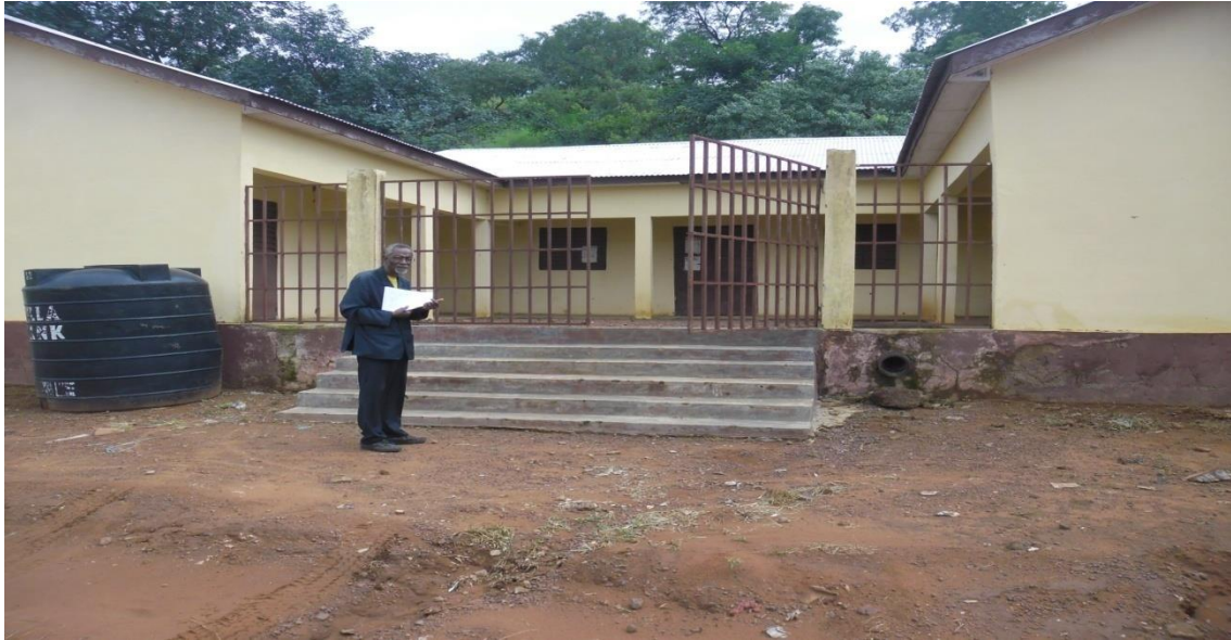
Bâtiment administratif de Siguirini (Financement CDLSMD)
