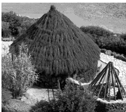
Capanne, che in sardo si chiamano pinnettas
