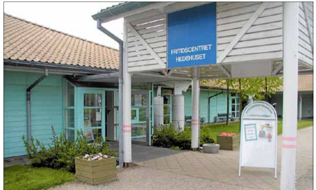
Hedehuset var blevet lidt træet og slidt, så nu er det blevet renoveret og fået nye møbler.
