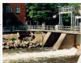
SÖRSTAFORS, 1937 0,7 MW EFFEKT
