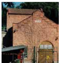
VÄSTERKVARN, 1915 2,5 MW EFFEKT
