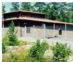
HALLSTAHAMMAR, 1991 15 MW EFFEKT
