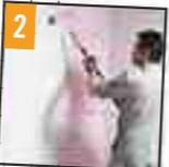
**2** Die TecTem® Grundierung vollflächig aufbringen und durchtrocknen lassen. Anschließend den TecTem® Innenputz auftragen.
