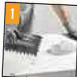
**1** Die Passstücke einfach mit dem Fuchsschwanz auf Maß schneiden. Die Dämmplatten werden vollflächig mit dem TecTem® Klebespachtel verklebt; eine Dampfbremse ist nicht erforderlich.
