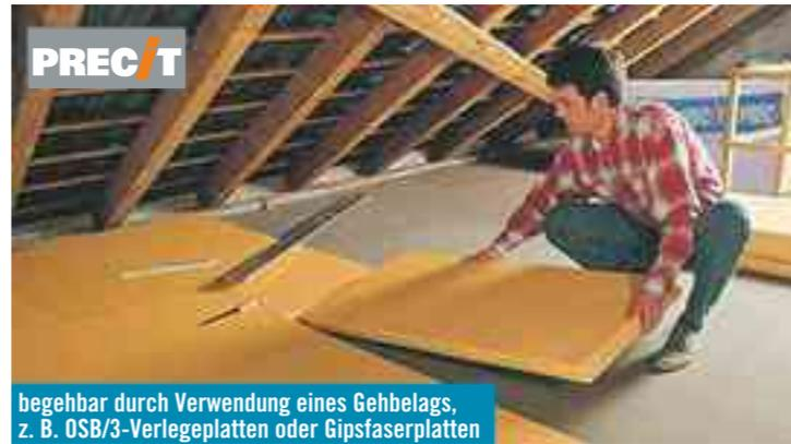
begehbar durch Verwendung eines Gehbelags, z. B. OSB/3-Verlegeplatten oder Gipsfaserplatten
