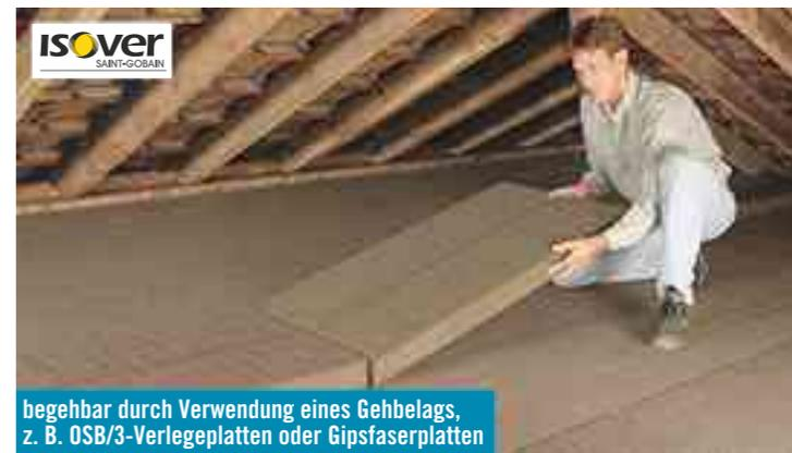
begehbar durch Verwendung eines Gehbelags, z. B. OSB/3-Verlegeplatten oder Gipsfaserplatten
