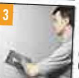
**3** Das TecTem® Gewebe einbringen und zuziehen. Nochmals TecTem® Innenputz auftragen, um die Armierung einzubetten. Für eine glatte Oberfläche TecTem® Glätte auftragen.
