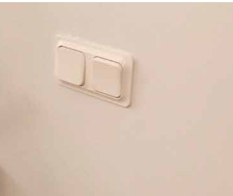
Problem: Att hitta väggbrytare då kontrasten är låg.
