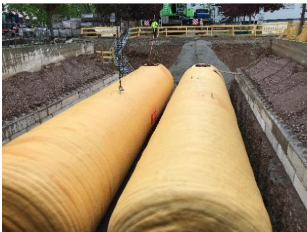
Abbildung 7 Erdtanks (li.) und Temperaturprofil des Erdreichs im Jahresverlauf 6 (re.)
