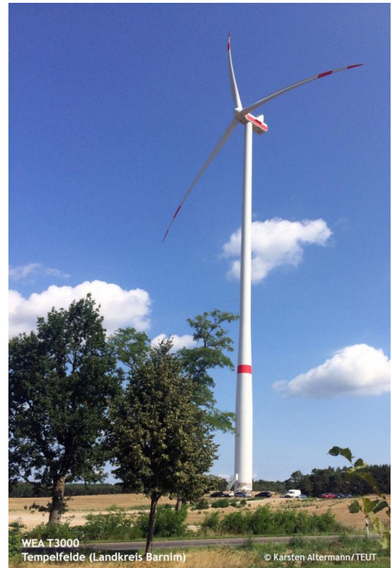
Abbildung 13 Windkraftanlage der Firma Teut, die Energie für Verbraucher, wie das Brauhaus Neulich produzieren.
