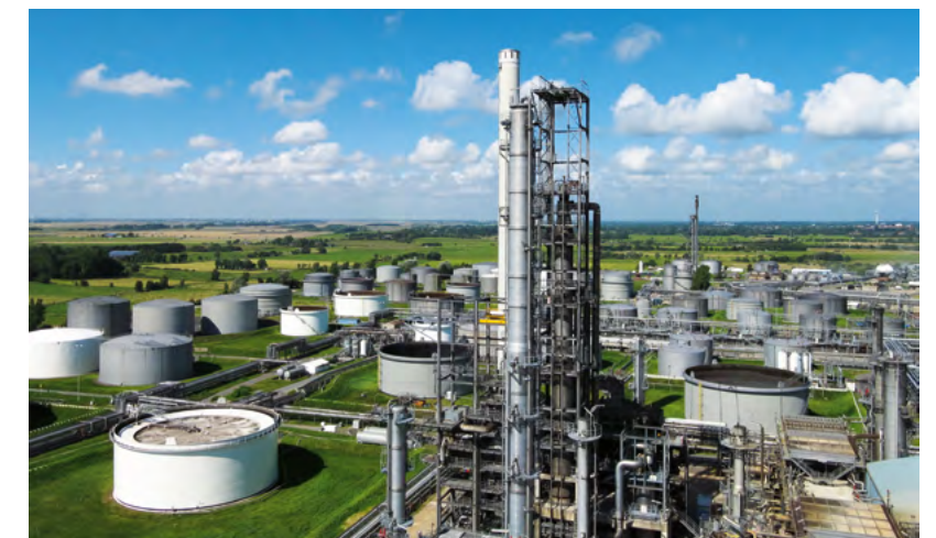
Raffinerie Heide: Grünes Kerosin für die Dekarbonisierung des Luftverkehrs
