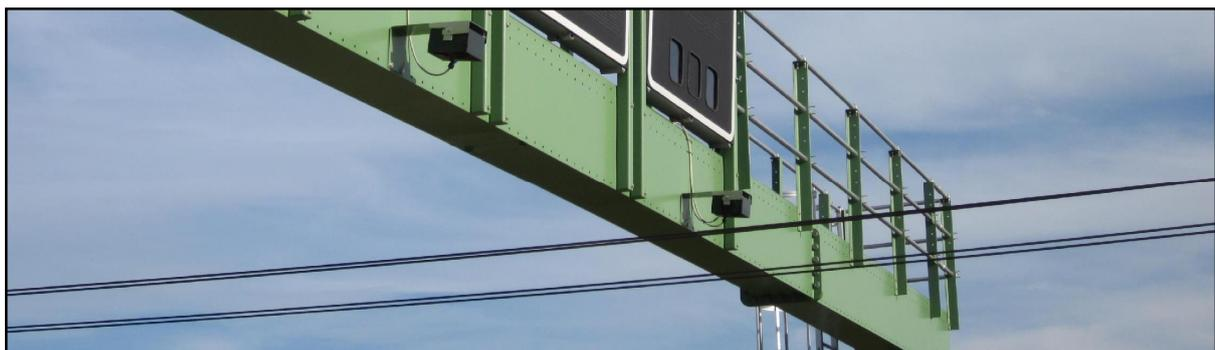
**Bild 56** Detailaufnahme zur Fahrdrahtführung unter der Wechselverkehrszeichenbrücke
