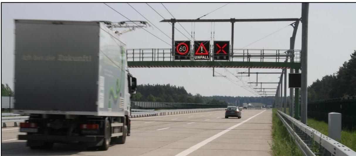
**Bild 41 Schilderbrücke mit Wechselverkehrszeichen auf der Versuchsanlage**
