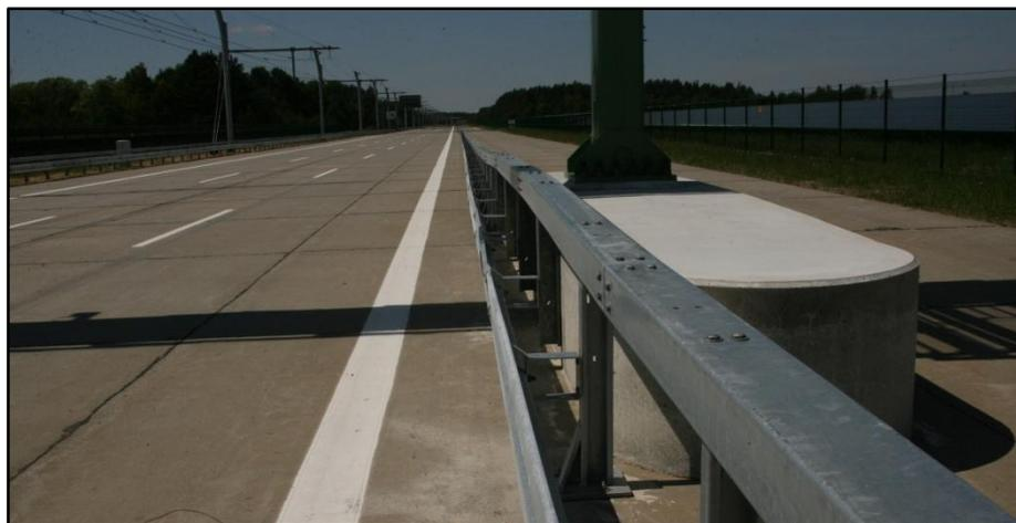
**Bild 52 Rückhaltesystem und Anprallssockel an der Wechselverkehrszeichenbrücke**
