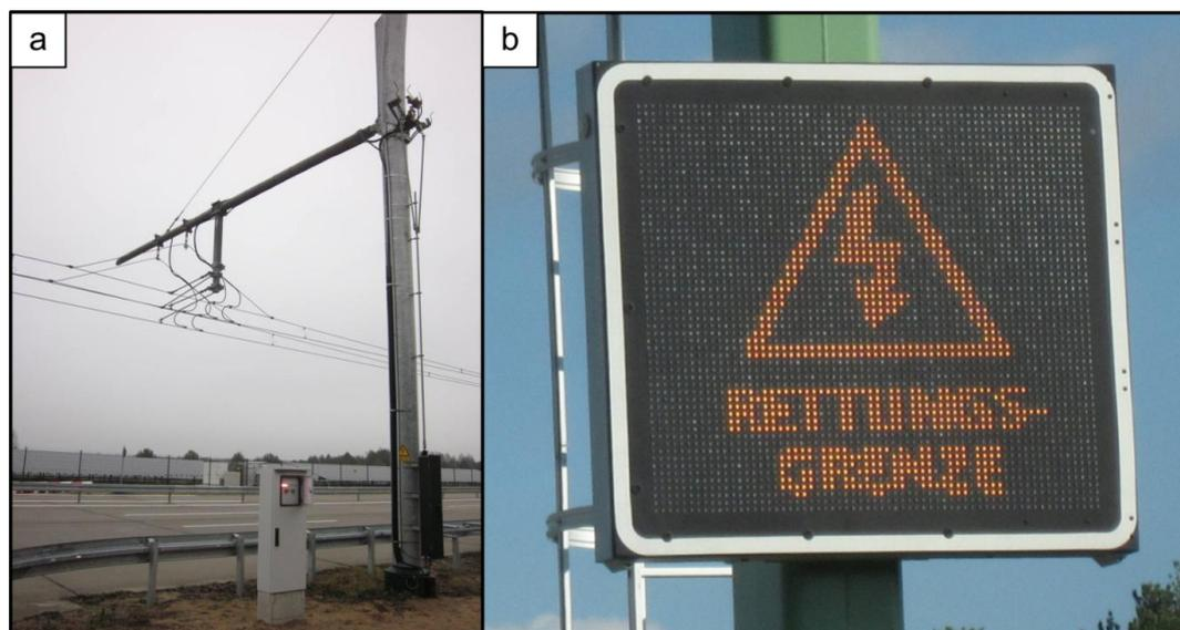
**Bild 9**      **Automatisierte Erdungsanlage mit a) Bedientableau und angetriebenem Erdungstrenner sowie b) aktiviertem Arbeiterschild**
