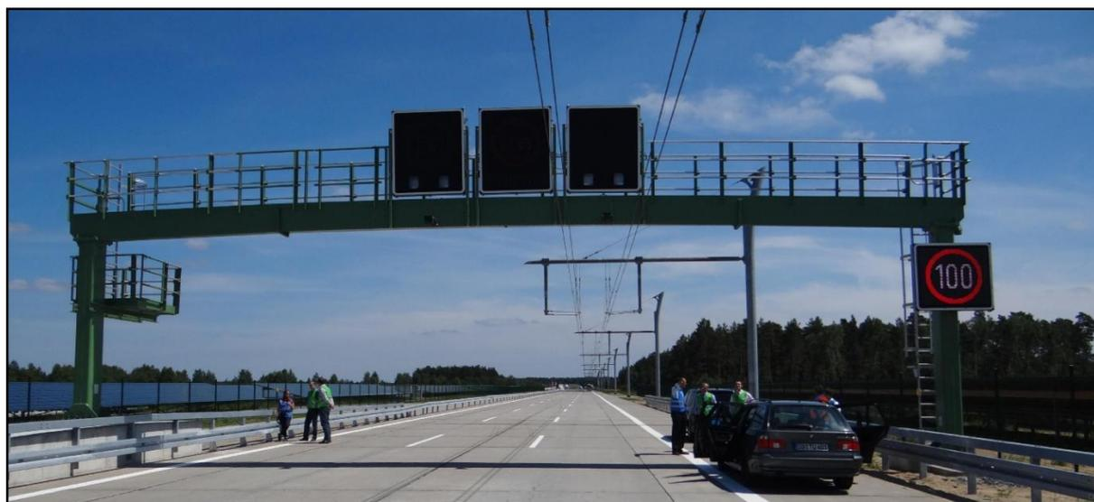
**Bild 50** Wechselverkehrszeichenbrücke mit 5,00 m Durchfahrtshöhe
