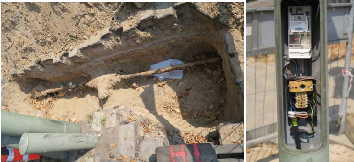
Abbildung 4: Aushubarbeiten zur Bereitstellung der 2. Phase und neuer Netzanschluss im Mast
