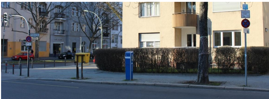
Abbildung 52: Ladesäule Handjerystraße und zugeordnete Parkstände
