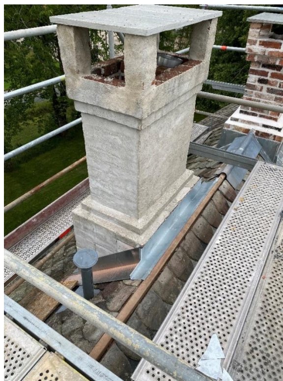
Bane Nor har gjennomført en restaurering av pipene pga. lekkasjer. Foto: Tore Collett-Moen.
