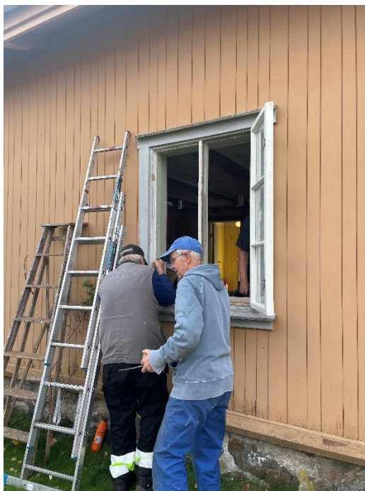
Innsetting av ferdigrestaurerte vinduer. Hans Kristian Mjølnerød og Stein Gjerløw. Foto: Svein Norheim
