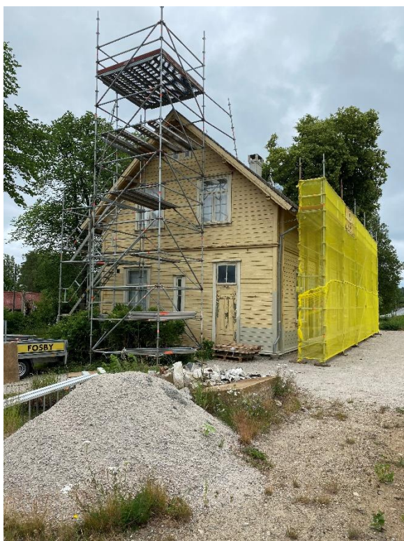
Bane Nor har gjennomført en restaurering av pipene pga. lekkasjer. Foto: Tore Collett-Moen.
