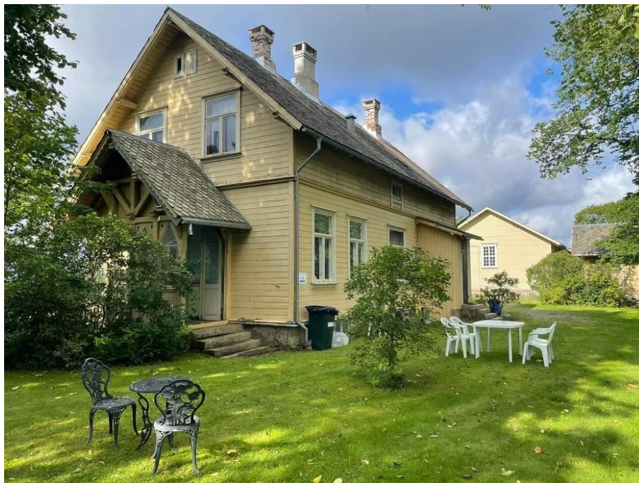
Stasjonsbygningen og deler av den fredete hagen. Foto: Tore Collett-Moen.
