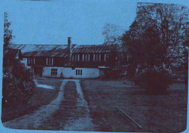
Garveribygningen slik den står i dag. Ytterveggene i 1. etg. ble byttet ut bit for bit rundt 1960.
