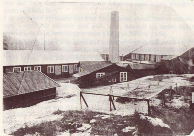
Bygningene til Aktieselskabet Munkholmens Dampgarveri, slik de sto 1914.
