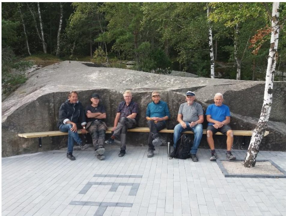
Endelig ferdig! Plattingen ved brygga på Skriverøa er fullført – en fornøyd og sliten gjeng. Nå også lettere tilgjengelig for de som har nedsatt funksjonsevne.
