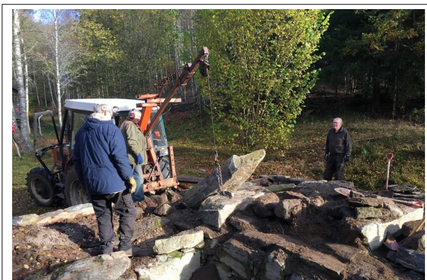
Elgåfossen – utbedring av grunnmuren til husmannsplassen Saga. Et arbeid som gikk over flere dugnadssamlinger. Foto: Svein Norheim.
