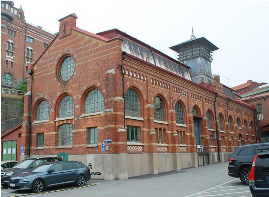
Kraftstationens västra fasad och norra gavel. Foto LKU 2021.
