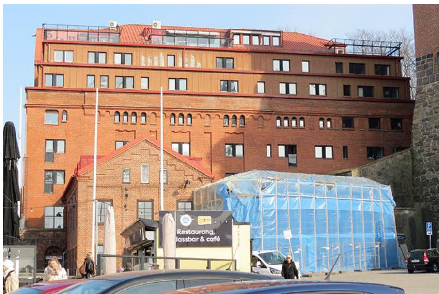
Bryggeribyggndens västra fasad. Här fanns tidigare lagerkällare. Den lilla tegelbyggnaden framför är sockerbrukets sadelmakarverkstad (nr 10). Foto ID 2022.
