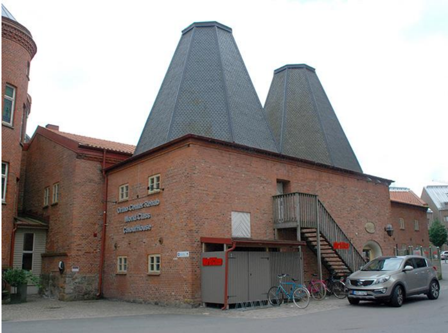
Mälteriets kölnor (torkrum vid tillverkning av malt) med sina karaktäristiska rökhruvar klädda med skiffer. Foto LKU 2021.
