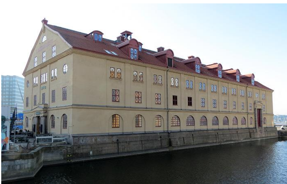
Frilagerhuset sett från andra sidan Rosenlunds-kanalen. Speciellt är frånvaron av kaj här, som beror på att båtarna lossade sin last direkt in i byggnaden genom den stora porten som syns till höger i bild. Foto LKU 2022.
