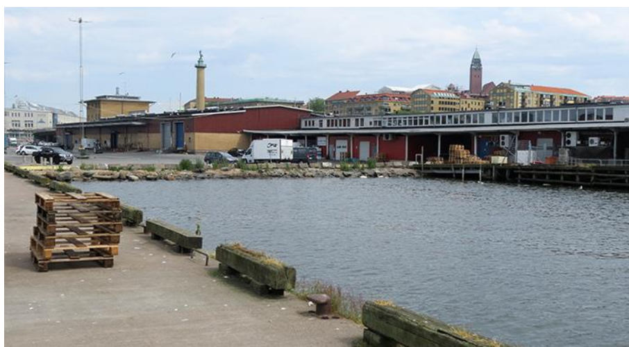
Bilden är tagen från (e), betongkaj uppförd på 1990-talet, och visar (g), administrationsbyggnad med auktionshall från 1993 längst till vänster i bild och höger om detta syns delar av (d), f.d. fiskhall B och Almqvistska huset. Foto ID 2021.
