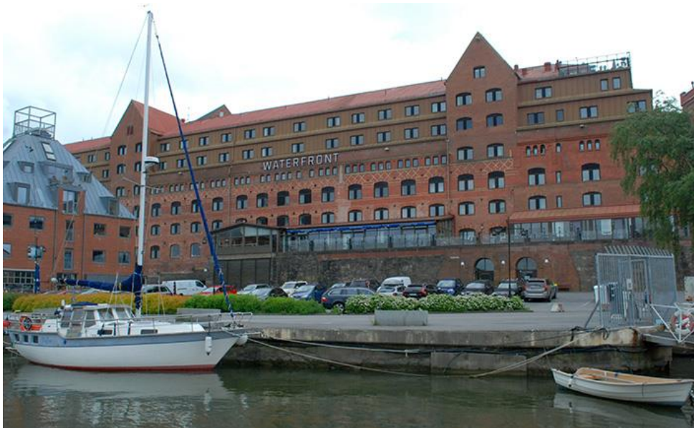
Här syns den mittersta och västra delen av den stora bryggeribygnaden, sedd från norr. Notera den höga stengrunden. Foto LKU 2021.
