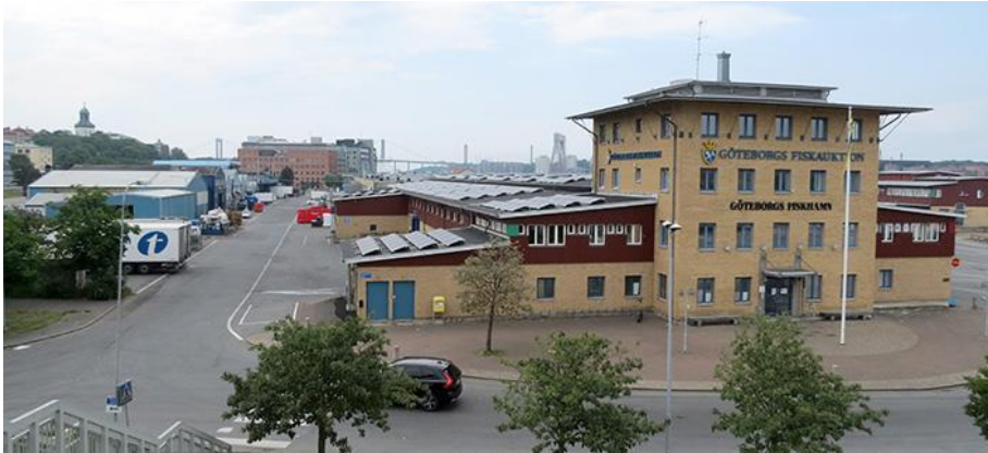
1993 stod Fiskhamnens nya administrationsbyggnad med auktionshall (g) klar. Foto ID 2021.
