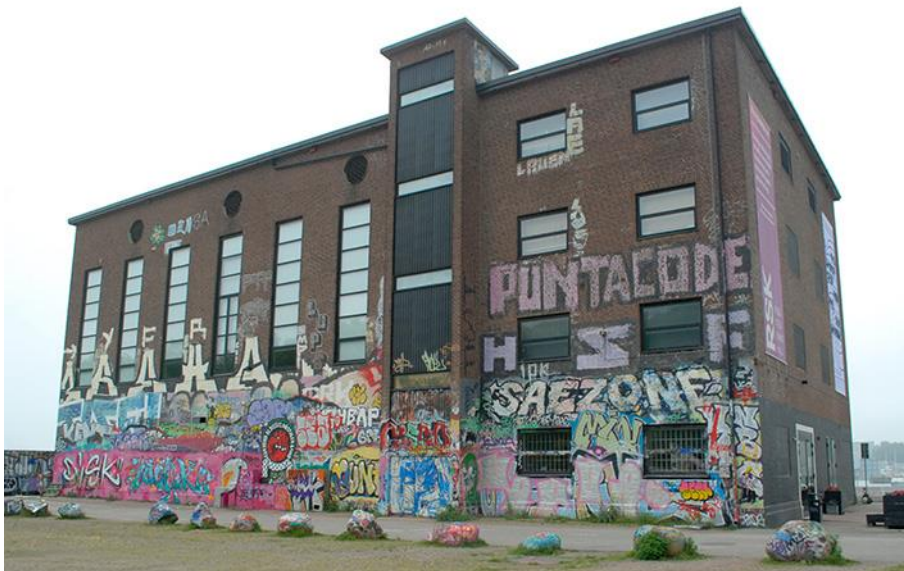
Sockerbrukets pannhus uppfördes 1941 och består av en enda stor hall med höga fönster. Bilden visar södra fasaden. Foto LKU 2021.
