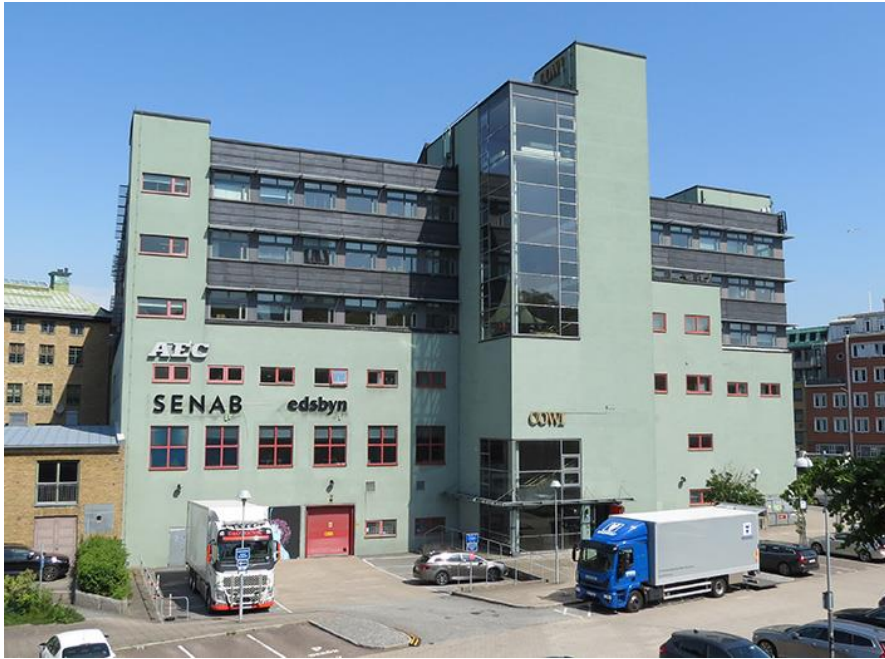
Fryshuset idag med det nya trapphuset centralt placerat mot söder. De mörka våningsplanen tillkom vid ombyggnaden 2002. Foto ID 2021.
