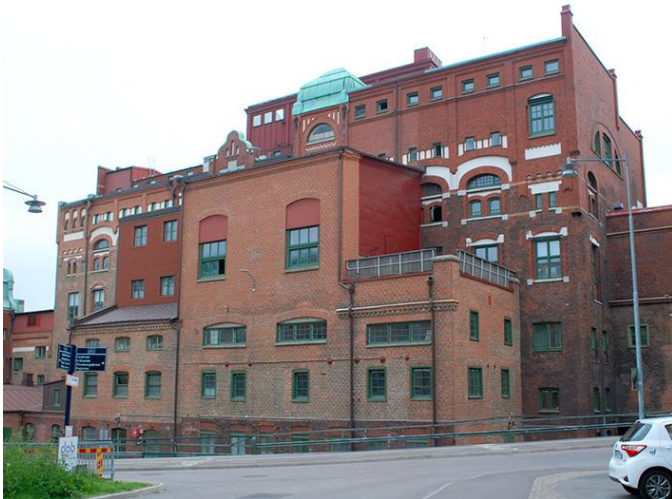
Ovan: "Gamla bruket" med sina många tak klädda med kopparplåt.
