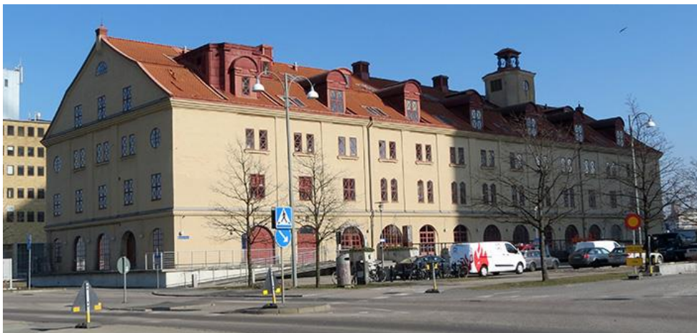
Frilagerhuset från väster. Foto LKU 2022.
