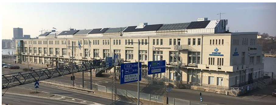
Amerikaskjulets södra fasad. Foto LKU 2022.
