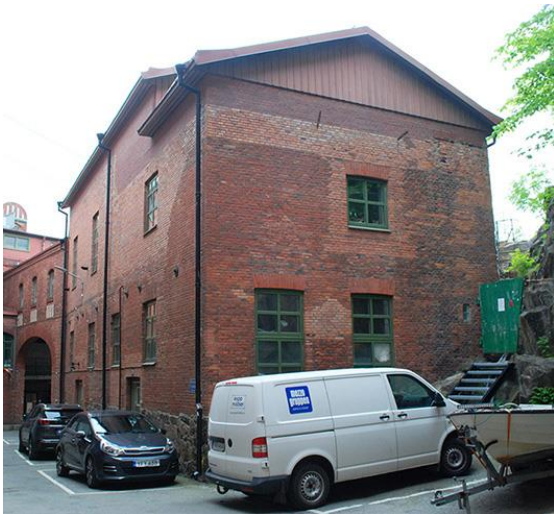
Byggnadens östra gavel. Troligen stod Johannes Ruths ångackumulator här innanför. Längst till vänster i bild skimtar valvet som förbinder byggnad nr 4 och nr 5. Foto LKU 2021.
