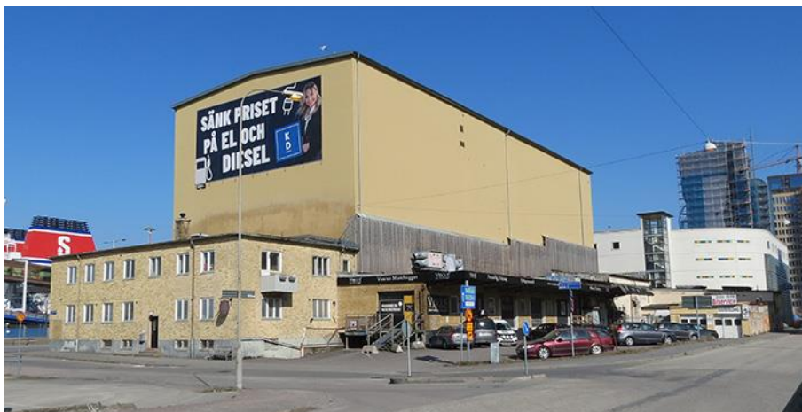
Kylhusets karaktäristiska fönsterlösa fasader mot väster och söder. Foto LKU 2022.
