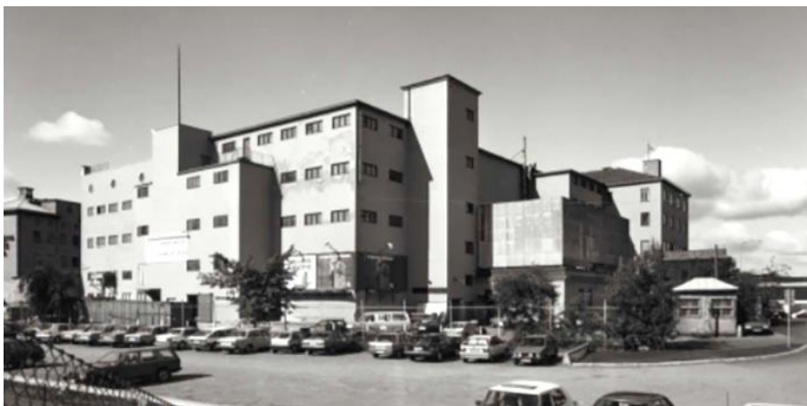
Fryshuset som det såg ut 1987, ännu präglad av 1940-talets funktionalism. Bilden är tagen från ungefär samma vinkel som den på föregående sida. Bild från hemsidan Det gamla Göteborg .
