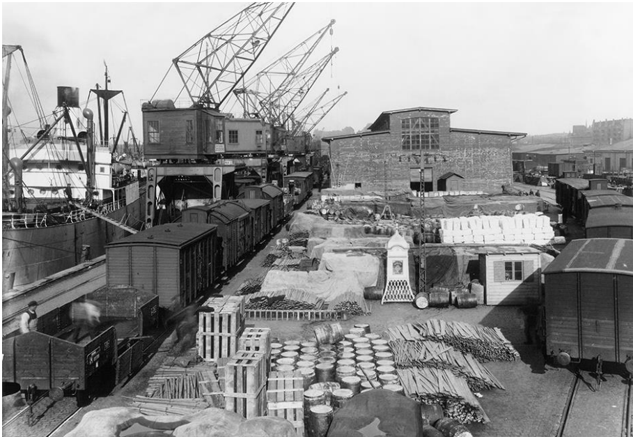
Styckegodshantering vid kajplats 32 vid Masthuggskajen på 1920-talet. Byggnaden är Magasin 6. Bild från Göteborgs Hamns hemsida.
