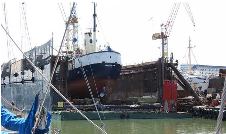
Stora dockan (G) är en flytdocka som köptes in 1977 som L-docka och byggdes om på varvet till en U-docka 1979. Foto Ida Dicksson 2020.
