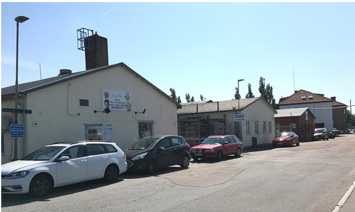
Smidesgatan 3-7. Byggnaderna uppfördes med ett litet kontor, pannrum, omklädningsrum och matrum ut mot gatan medan resten av byggnaden utgjorde verkstad. Foto Ida Dicksson 2020.
