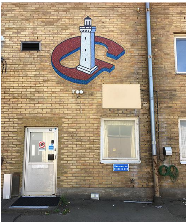
Gjutjärnsgatan 12. På verkstadsbyggnadens norra fasad finns logotypen för Göteborgs Hamn. Foto Lena Knutson Udd 2020.
