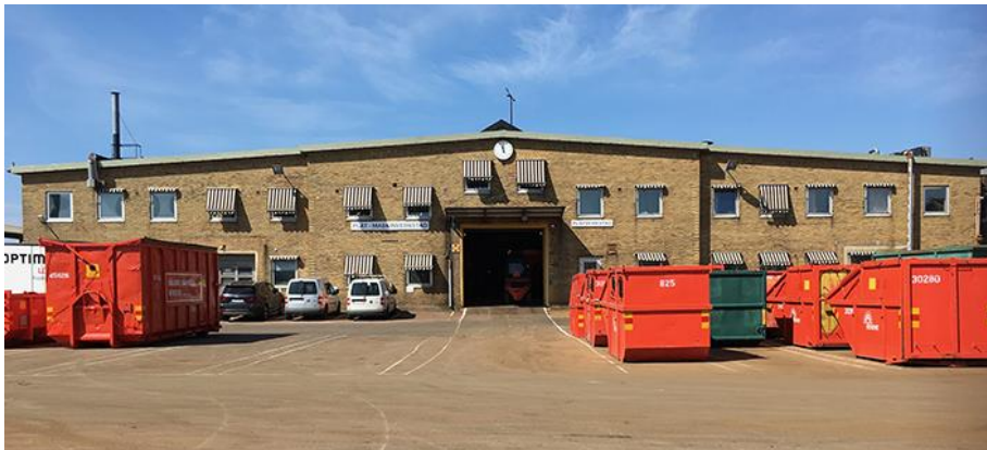
Vänster: Södra delen av den stora verkstadsbyggnaden på Gjutjärnsgatan 12, sedd från söder. Foto Lena Knutson Udd 2020.
