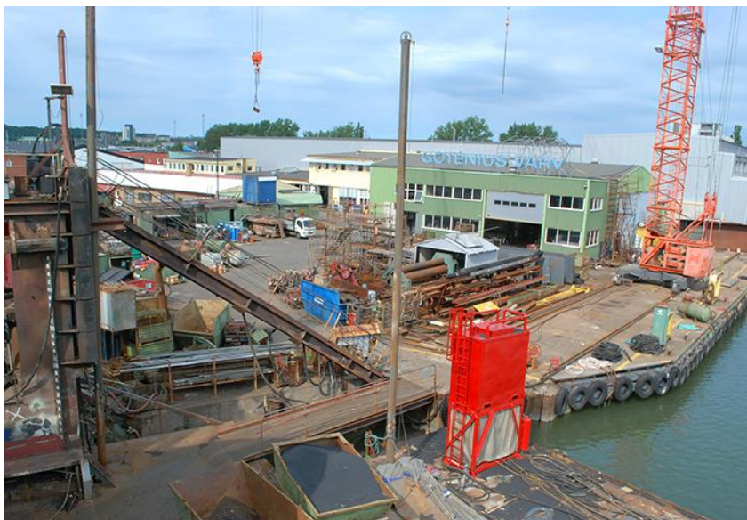
Varvsområdet med plåt- och rörverkstaden och utrustningskajen, sett uppifrån Stora dockan. Utmärkande för Gotenius är småskaligheten och den komprimerade miljön, jämfört med många andra varv. Foto Lena Knutson Udd 2020.
