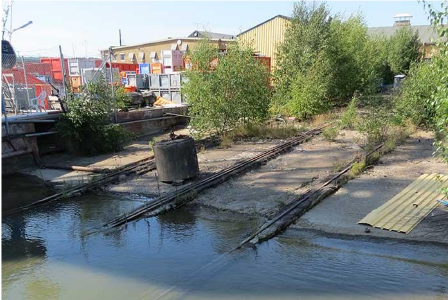
Gjutjärnsgatan 12-14. Den mindre slipen öster om kranen har inte kvar sin slipvagn eller sitt maskineri. Foto Ida Dicksson 2020.
