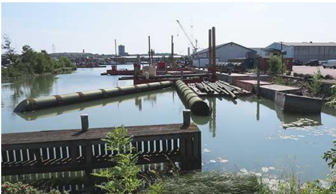
Lergodsgatan 1. Här låg tidigare den gamla Ringkanalens inlopp och några av öns första industrier. Även idag pågår verksamhet med marin anknytning. Här utför Frog Marine Service marina tjänster riktade mot fartyg och handelsflottan. Foto Ida Dicksson 2020.
