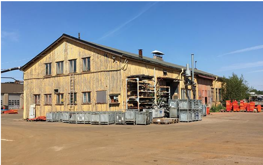
Gjutjärnsgatan 12. Byggnaden bär spår av många års användning utan några större om- eller tillbyggnader och används i hög grad än idag som verkstad. Foto Lena Knutson Udd 2020.
