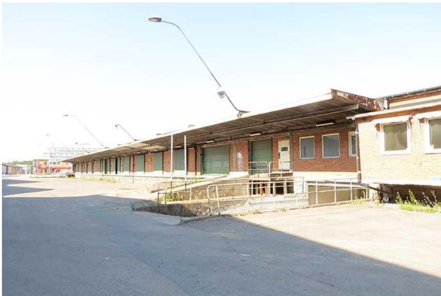
På Bilspeditioners lagerbyggnads västra fasad syns ännu äldre armatur och trafikspeglar. Foto Lena Knutson Udd 2020
