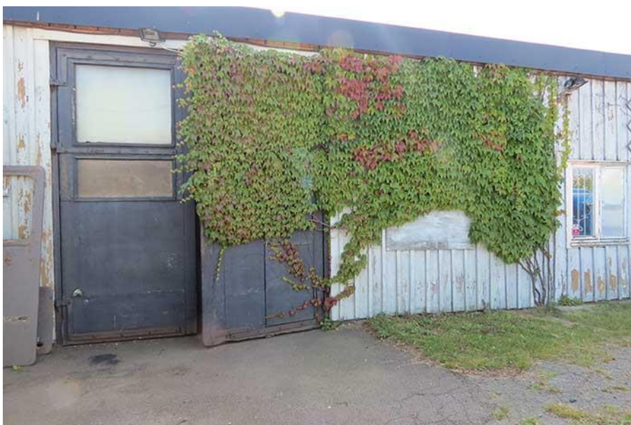
Den stora industriporten ser ut att vara original från ombyggnaden 1970, om inte äldre än så. Foto Lena Knutson Udd 2020.
