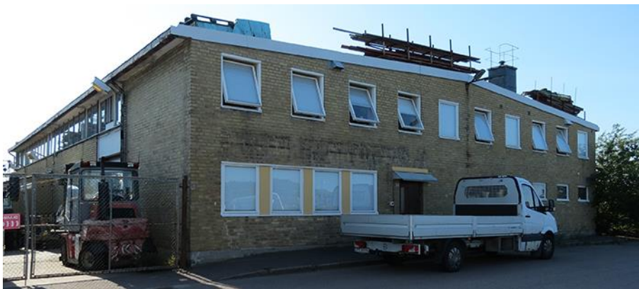
Kolgruvegatan 14. På fasaden syns spår efter texten "Brukens Härdverkstäder AB". Foto Ida Dicksson 2020.
