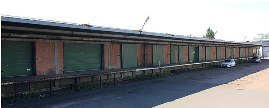
Raden av portar fortsätter även på innergården, här västra byggnadslängan sedd från innergården. Foto Lena Knutson Udd 2020.
