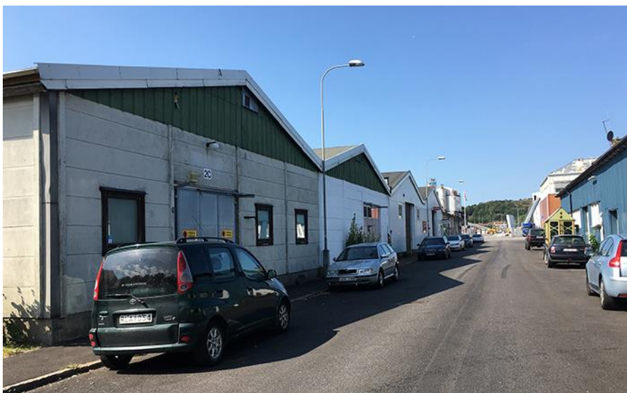
Fasaden mot Kalkbruksgatan. Foto Lena Knutson Udd 2020.
