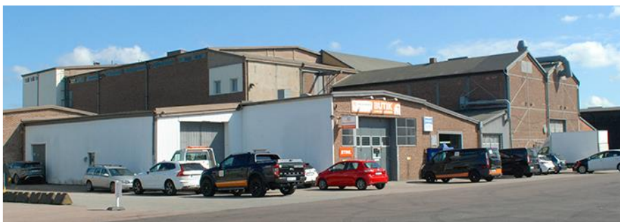
Fabriken sedd från nordväst. Foto LKU 2021.
