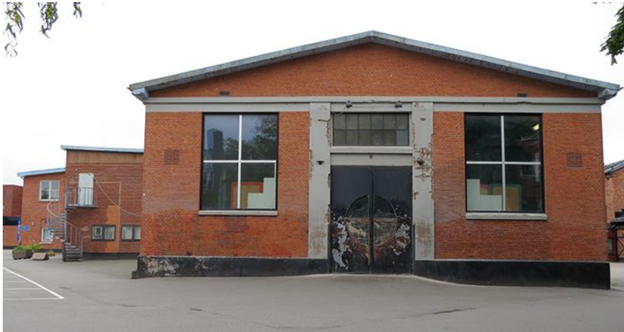
Gavelns småspröjsade fönster har bytts ut mot moderna fönster. Jämför med ritningen nedan. Foto ID 2021.
