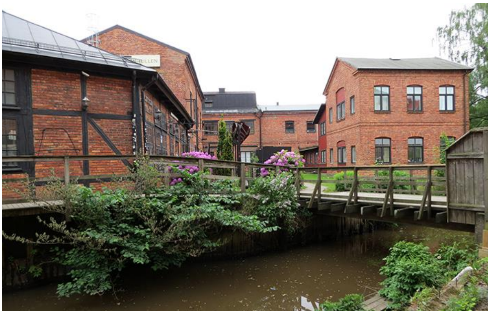
Den äldre delen av Göteborgs Bult- & Nagelfabrik ligger alldeles intill Kvillebäcken. Foto ID 2021.
