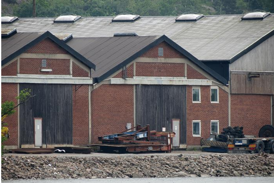
Söderberg & Haak AB sett från andra sidan älven. Foto ID 2021.
