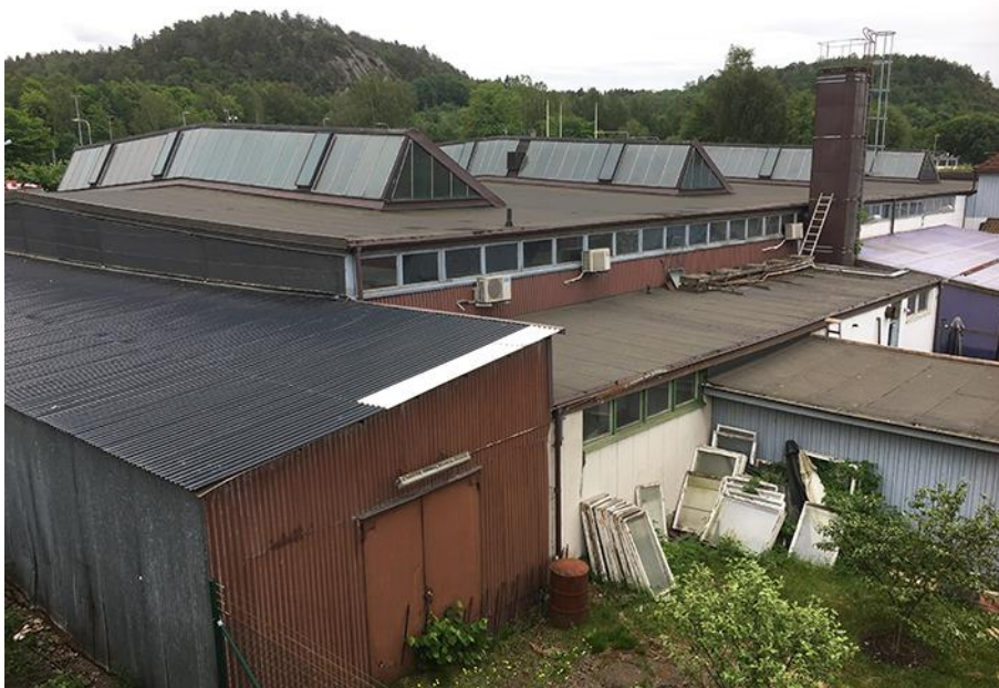
Färgfabrikens lagerbyggnad från 1958 finns kvar idag, med sågtands-tak, fönster och skorsten relativt bevarade. Foto LKU 2021.
