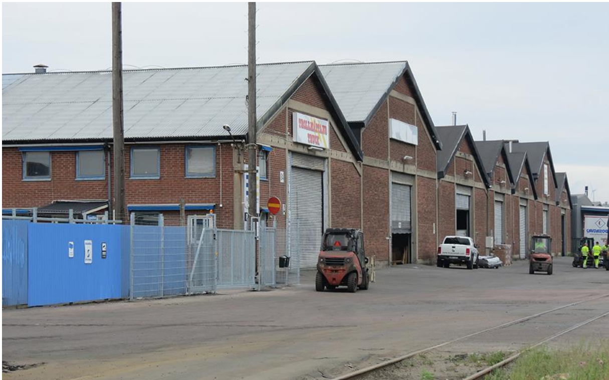
Bilden visar den norra byggnadskroppen med adressen Marieholms-gatan 84 C, som består av sju sammanbyggda takskepp, uppförda 1958-1959. På ritningen nedan syns delen som tillkom 1959. Foto ID 2021. Ritning från Stadsbyggnadskontoret. Ritningen är beskuren.
