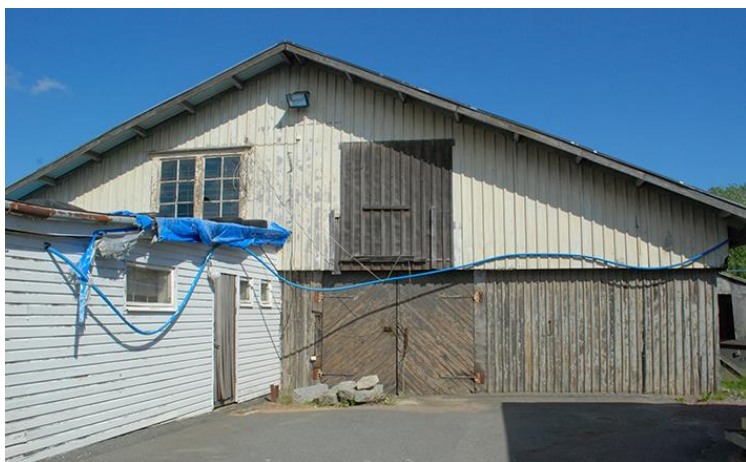
Waernska upplaget, västra gaveln med äldre fönster och dörrar samt fasader av trä med locklistpanel. Byggnaden är svårtillgänglig från det här hållet. Foto LKU 2021.
