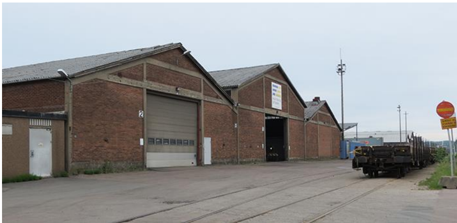
Söderberg & Haaks första magasin uppfördes 1957 på Marieholmsgatan 84 A. Här syns gavlarna mot öster. Anläggningen används idag av olika verksamhetsutövare och en del transporter sker fortfarande med järnväg.
