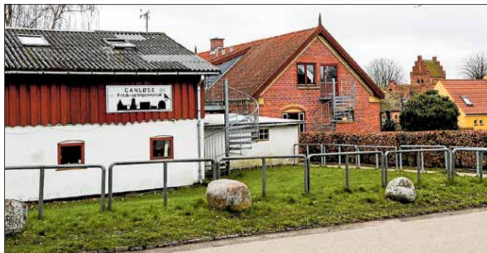
De tidligere driftsbygninger er arkitektonisk ordinære og i ringe tilstand, så de kan rives ned, men en ny bebyggelse skal også fremstå som tre længer.
