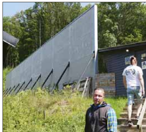
Mot den övre skjutbanan har en bullervägg byggts.
