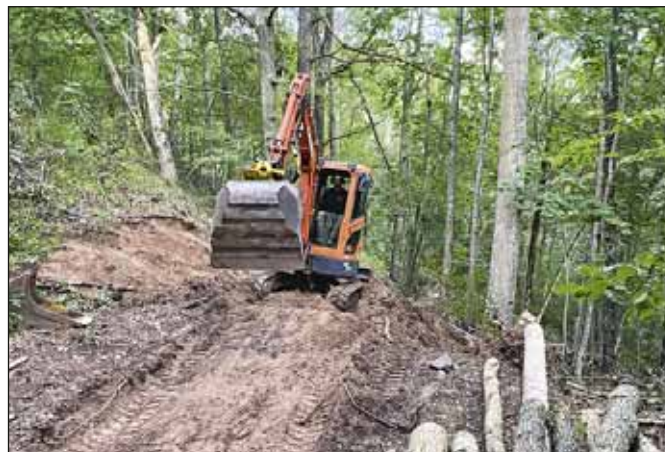
För att få ordning på slänten och terrängen behövdes en grävmaskin.
