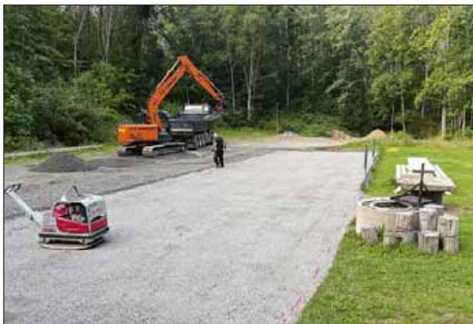
Rullstolsburna behöver fast underlag till rullstolarna så parkeringen behövde asfalteras.
