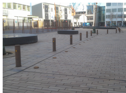
Pullerter og markeringssøm - Grønnegade, Odense
