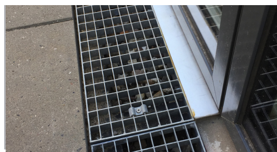
Dørprofiler findes i standard 50, 70 eller 100 mm og skrues fast på gitterristen.
