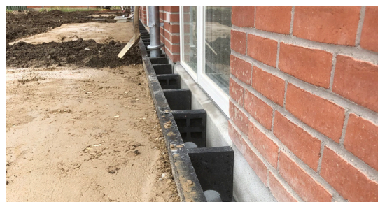
Når grusmaterialet foran underdelene er udlagt, følger underdelene perfekt bygningens facade.
