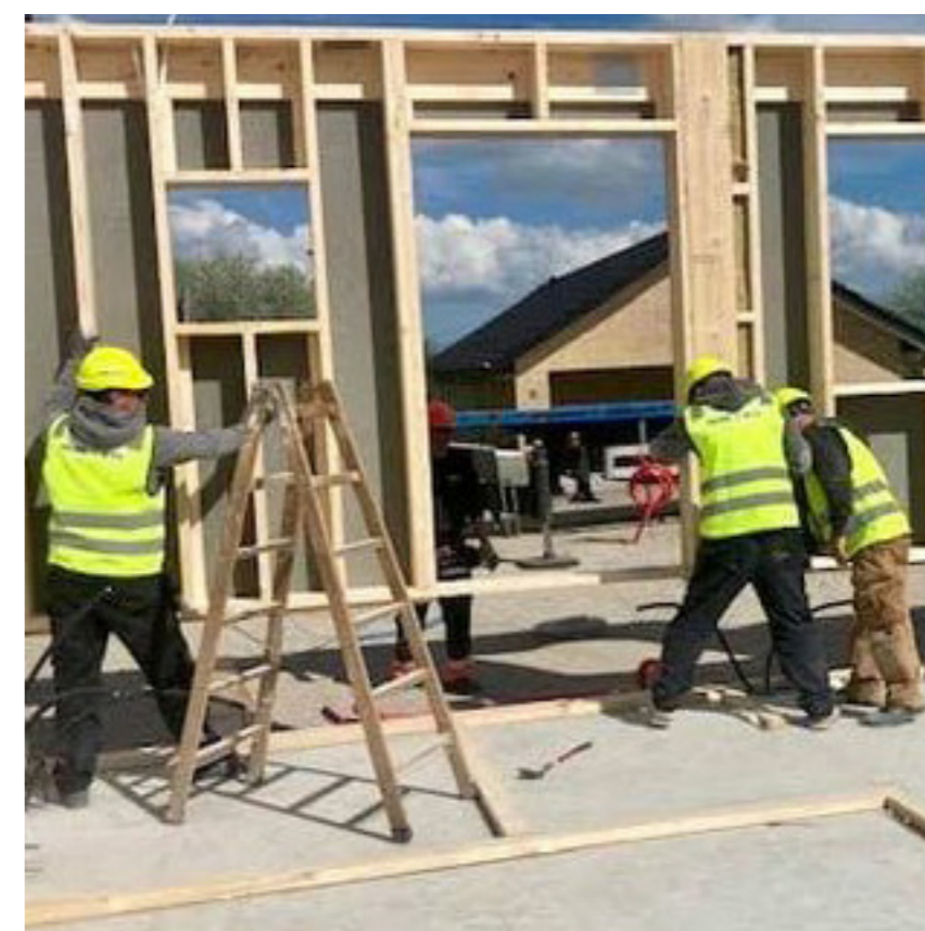
Foto: Huse-Byg Aps. Opførelse af 29 boliger i Jystrup 2022
