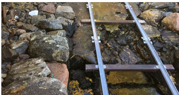
Slipskinne på ujevnt underlag. Lie
