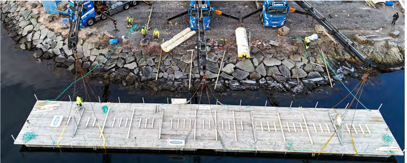
Lekter NOORA på 5x34 meter med fremdrift tilpasset brobygging
