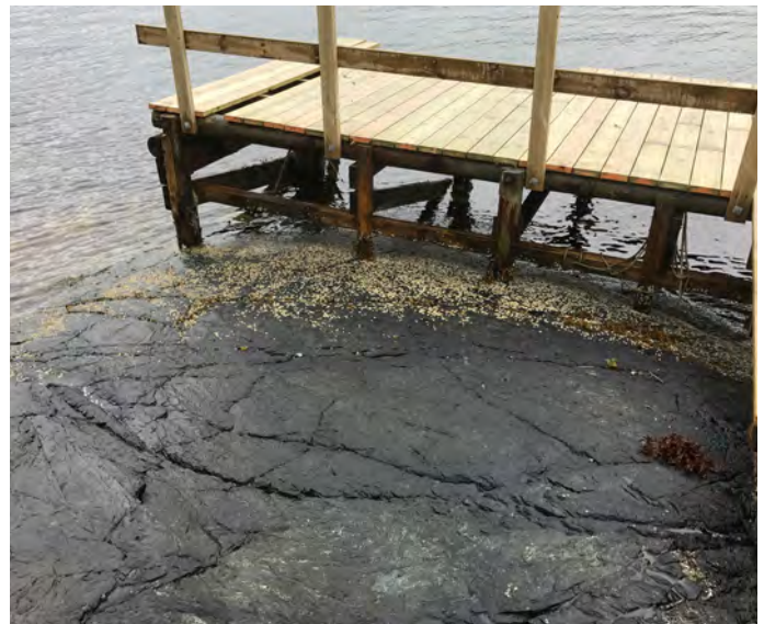
Bytting av kaidekke, Bjørøy
