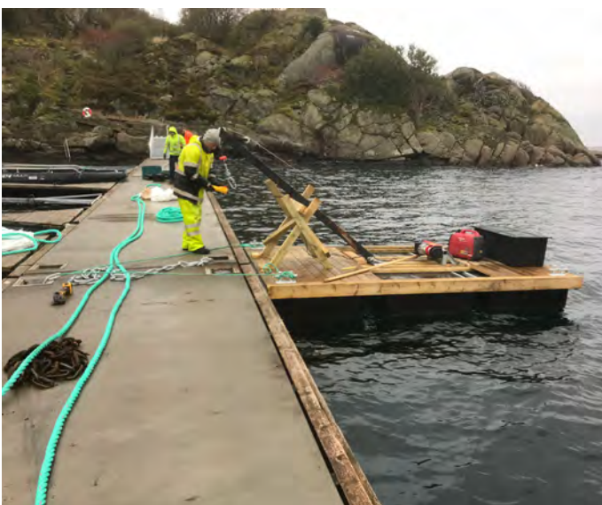
Tilsyn/service - bytting av forankring, Lyngdal
