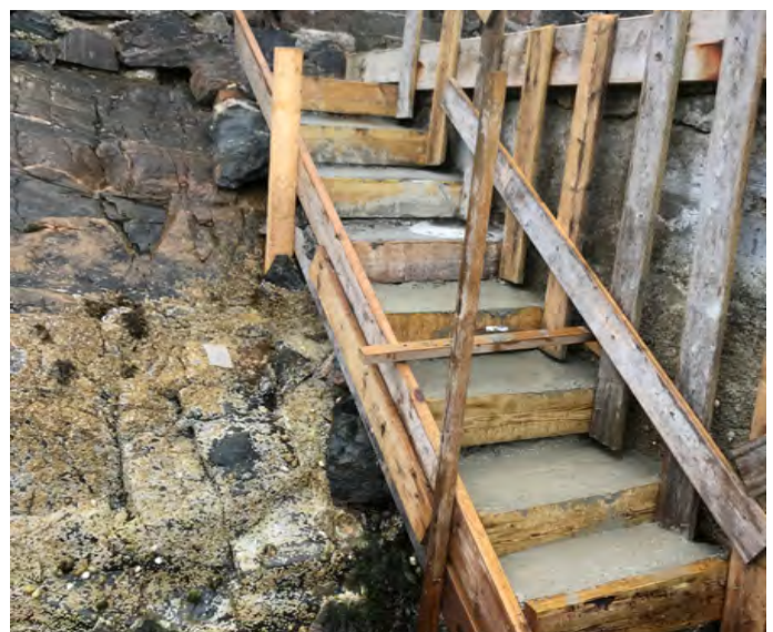
Rehabilitering av trapp
