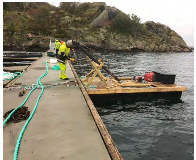
Tilsyn/service - bytting av forankring, Lyngdal
