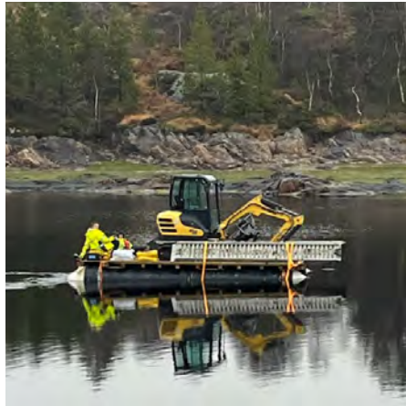
Unni med gravemaskin 3 tonn
