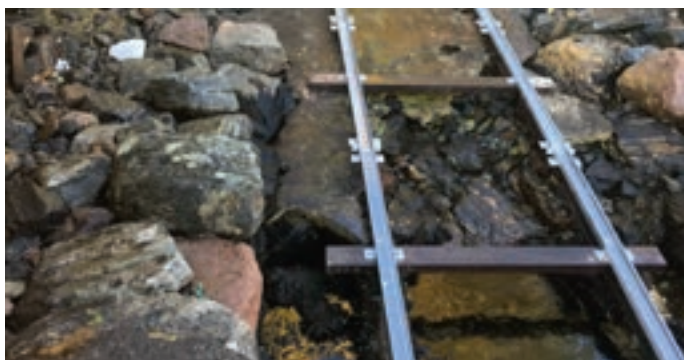
Slipskinne på ujevnt underlag. Lie
