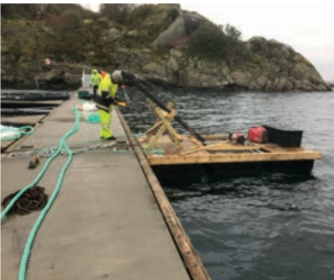
Tilsyn/service - bytting av forankring, Lyngdal
