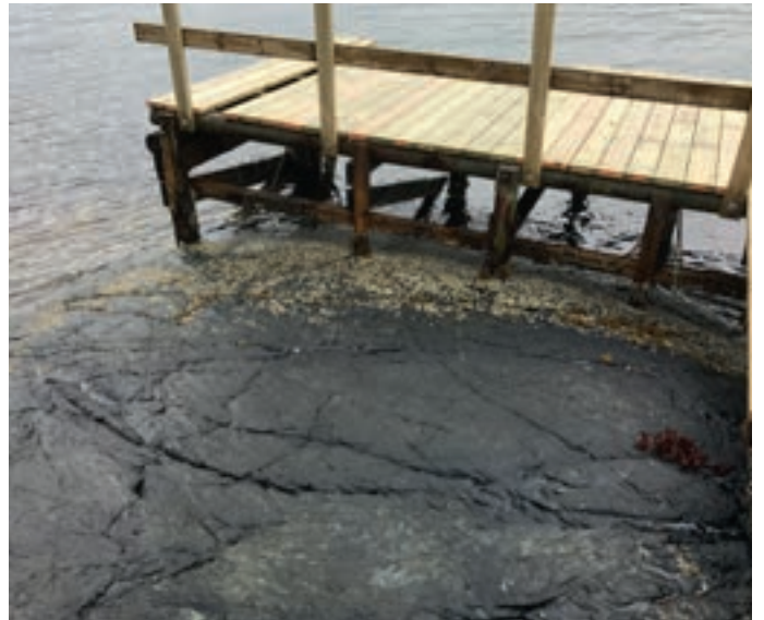
Bytting av kaidekke, Bjørøy
