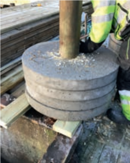
Vekting av trestolper (brakkvann)
