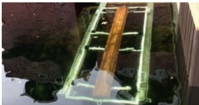
Slipskinne 3 meter ytterst, fritt heng. Eidsvåg
