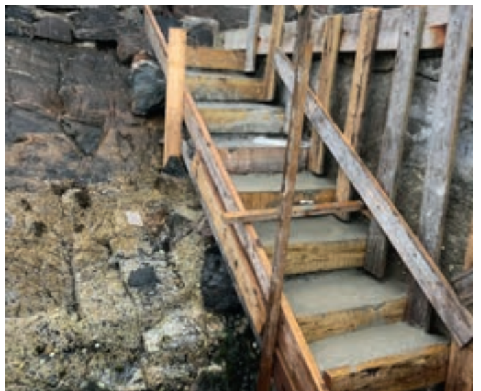
Rehabilitering av trapp
