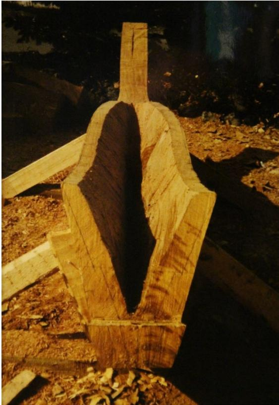
*Frisches Holz ist leichter zu bearbeiten, da die Zellen noch im Vollbesitz ihrer Säfte sind, und der Stahl des damaligen Werkzeugs war perfekt für diese Aufgaben gehärtet. Er musste allerdings des öfteren nachgeschliffen werden.*
