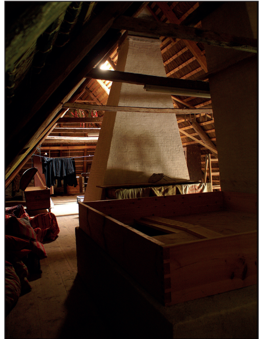
Loft over beboelsen - med de store kølle-skorstene. I forgrunde ses køllekassen til tørring af spiret malt. Bingen står foran køkkenskorstenen i baggrunden.
