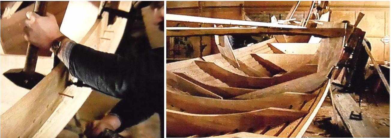
Das Schiff im Bau.
