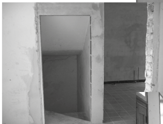
Billeder fra toiletter, da murerne er færdige.
