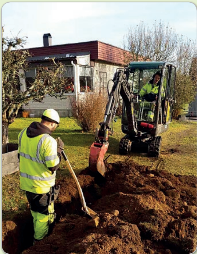
Emil Gustavsson och Tommy Janholm är männen som utfört arbetet med nedläggningen av fiberrören.
